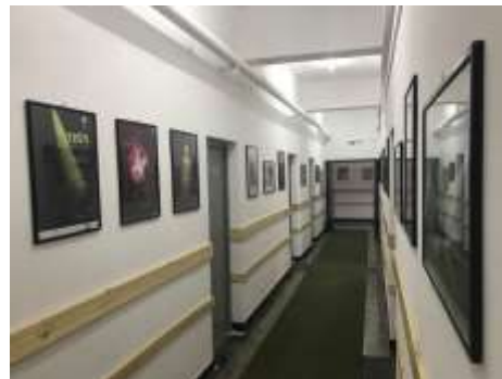
Renovarea holului din zona administrativă a instituției
